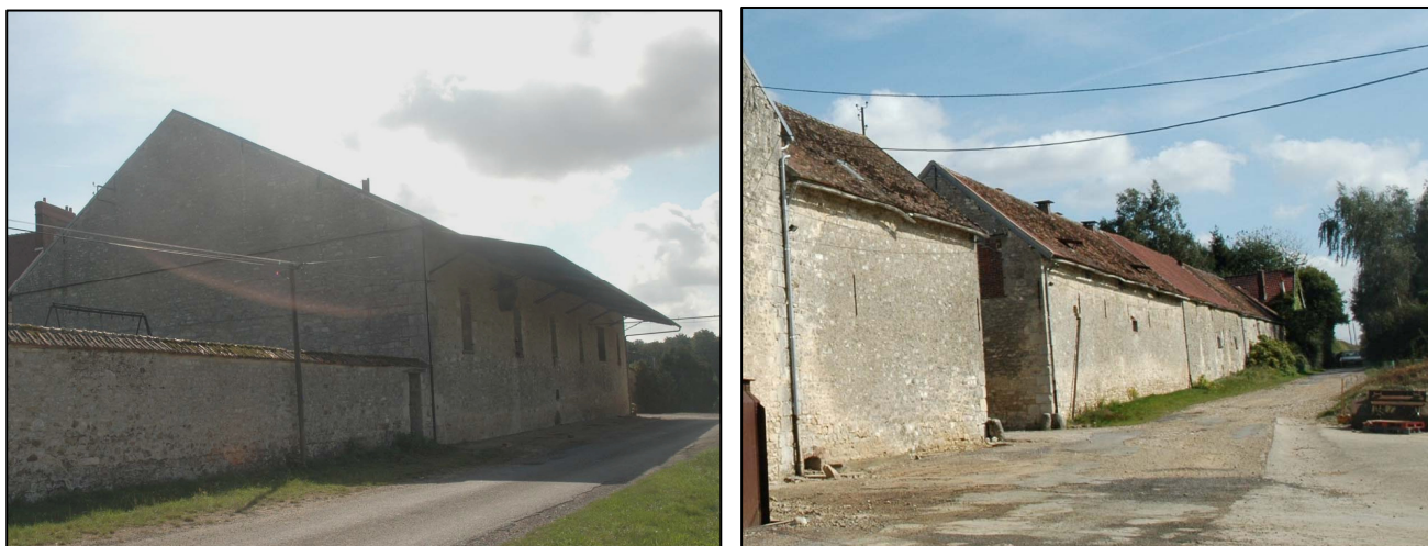
Les anciennes constructions agricoles utilisent les matériaux traditionnels et présentent des volumes imposants. Les plus remarquables d'entre elles sont reconnues au titre de l'article L.123-3-1 du Code de l'urbanisme, le changement de destination est autorisé.
