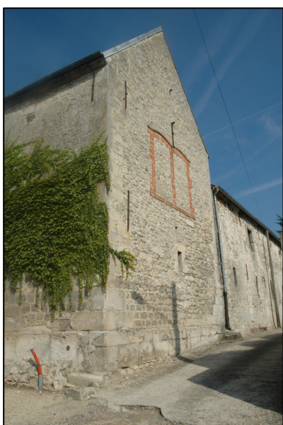
Exemple de construction en moellon avec présence de briques (en encadrement d'une ancienne ouverture)
