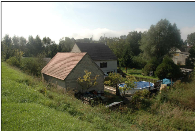
La construction sise parcelle 147 est située en contrebas des axes qui la longent. La route surplombe la construction qu'on aperçoit au premier plan.
